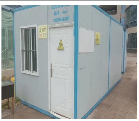
医疗废物暂存间
